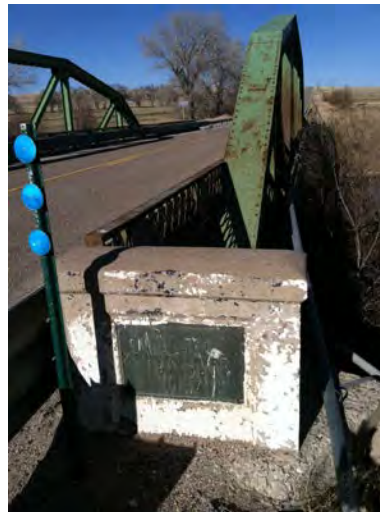
Purgatoire River Bridge, 2014
